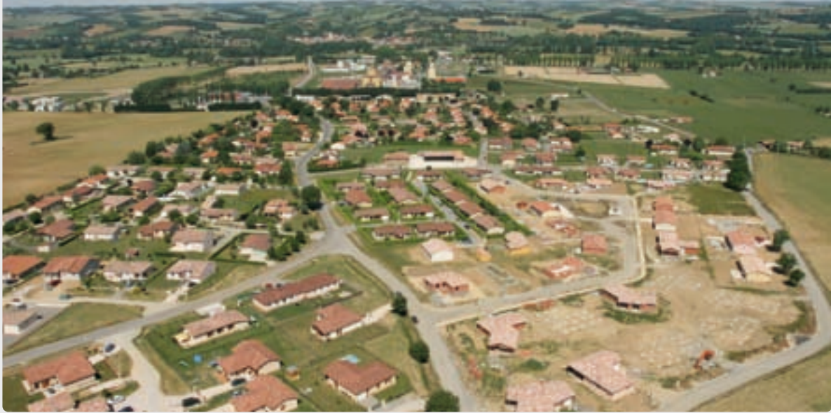
Création d'une voie douce entre le vieux village et la Ramondère, embellissement et sécurisation des entrées de ville
